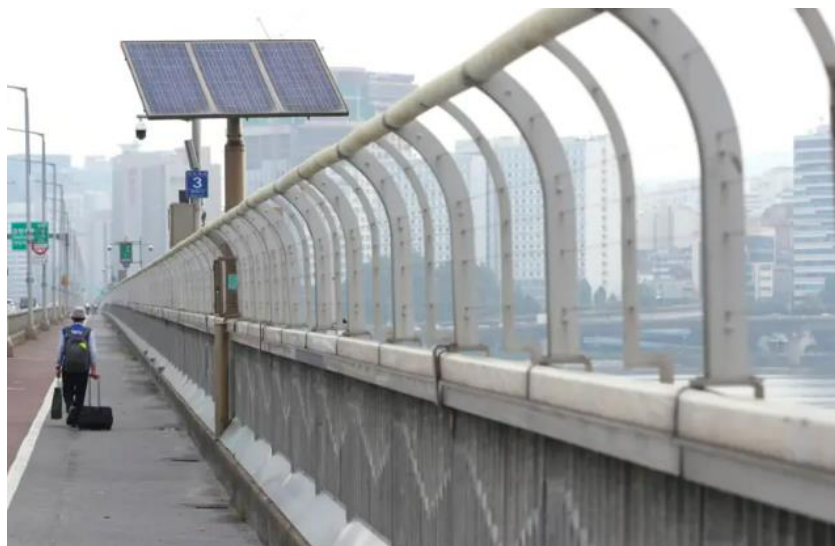
Mallas instaladas en el puente Mapo 2023. Fuente: New1 en BBC 150
